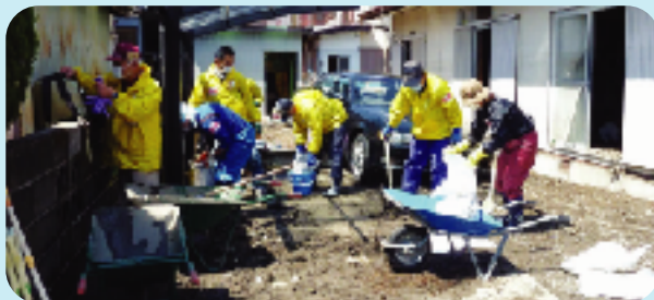
10人ほどのグループで、流れ込んだ泥をスコップで取り除き、土のう袋に詰めていきます
