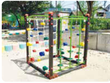
遊具の新設(池田保育園)
