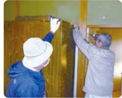
固定器具の取り付けの様子
